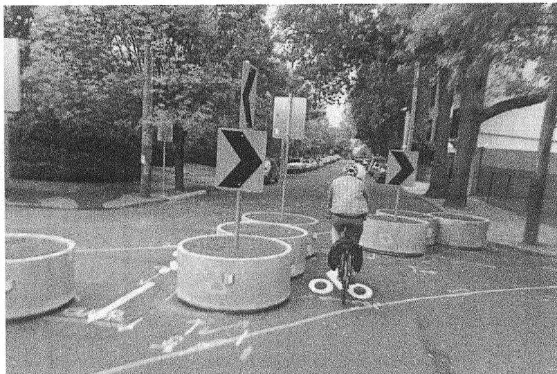
Foto 25 - Divisor de tráfico temporal usado en la ciudad de Portland, EEUU Fuente: Public Works Los Angeles, 2020
