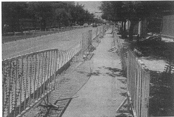
Foto 20- Resguardo de Peatones en Av. Fernando García Roel en Distrito Tec Imagen: Monterrey, N.L. Fuente: Distrito Tec, 2019
