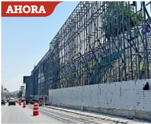
El municipio retiró el monumento durante la instalación de la estructura que sostendrá la mega pantalla.
